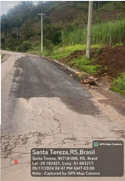
META 11: Restabelecimento Pavimentação Asfáltica Rota Caminhos do Pão e do Vinho – Trecho km 50+970 a 50+990 – Comprimento 20 metros e largura 7 metros
