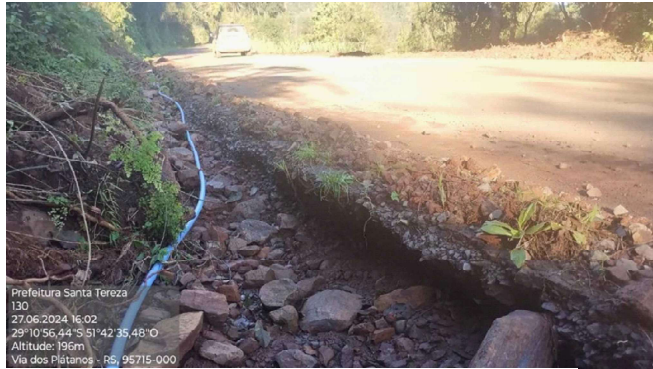
META 4: Restabelecimento da Estrada da Linha 130, Trecho 4 (estacas km 0+960 a 1+040)
