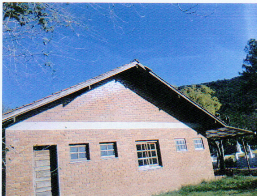
Fig 4 Fotografia fachada norte do prédio
