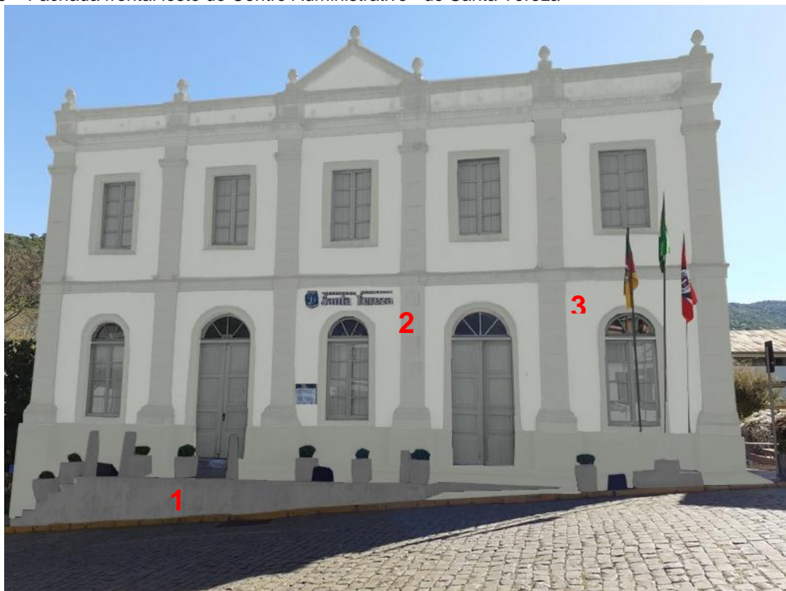
Figura 3 – Fachada frontal leste do Centro Administrativo de Santa Tereza
