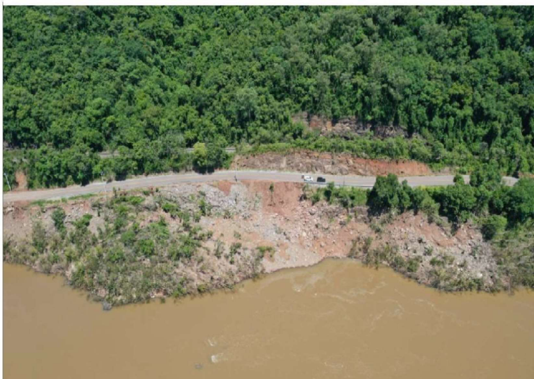
Imagem 22: imagem do talude avariado ainda na inundação de 18 de novembro de 2023; Coordenadas: latitude 29°10'59,29"S e longitude 51°44'2,07"O; Fonte: Parecer Técnico Documento UAA nº 165/2024 – Unidade de Assessoramento Ambiental Ministério Público do Rio Grande do Sul; Data das imagens: 27 de dezembro de 2023 (parecer técnico em anexo ao plano de trabalho).
