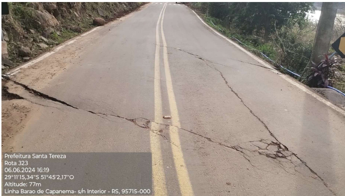
Imagem 67: trecho de pavimentação atingido. Necessária a retirada do pavimento danificado, execução de sub-base, base e pavimentação em CBUQ;
