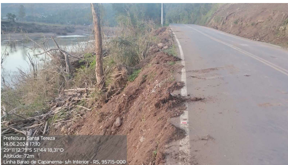
Imagem 34: bordo de pista avariado. Coordenadas: latitude 29°11'12,79"S e longitude 51°44'18,31"O; Fonte: o autor; Data das imagens: 14 de junho de 2024.
