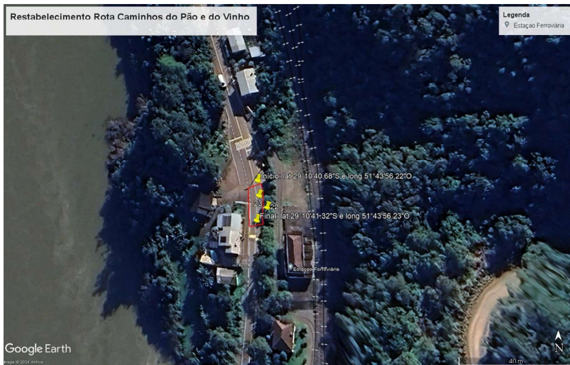
Imagem 68: localização, trecho de pavimentação atingido, com 20 metros de extensão e 7 metros de largura
